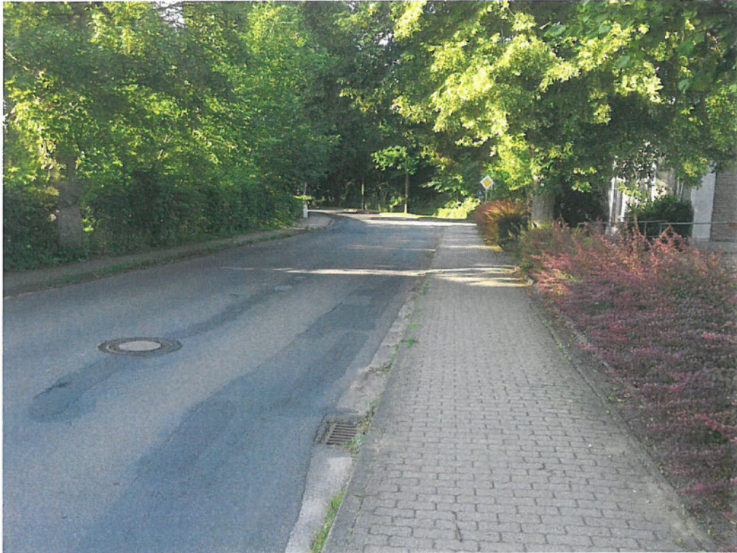
Bild 2: Blick auf die Einmündung "Bergstraße" aus Richtung Itzehoe kommend, im Kurvenaußenbereich hinter der Einmündung das Gelände des geplanten Netto-Marktes
